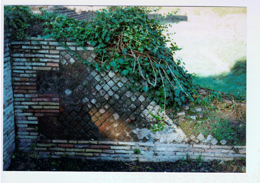
Abbildung 6: Eigene Photographie der Grundmauer eines kleineren, älteren, Privatbades am Ostrand von Ostia, bestehend aus opus testaceum und opus reticulatum (Region II):
